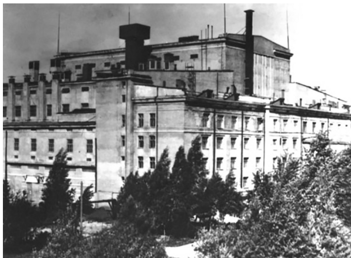
Здание цеха № 1 с установкой СУ-20
