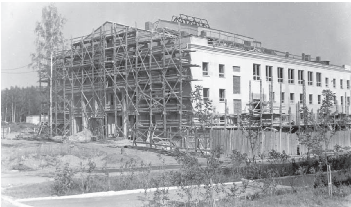
Строительство Дома культуры.
