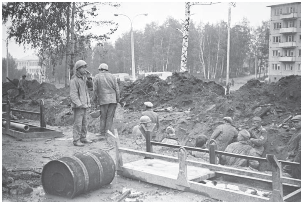
Строится дом по ул. Семёнова 10 г. Озерска. Фото Г.А.Золотарёва.
