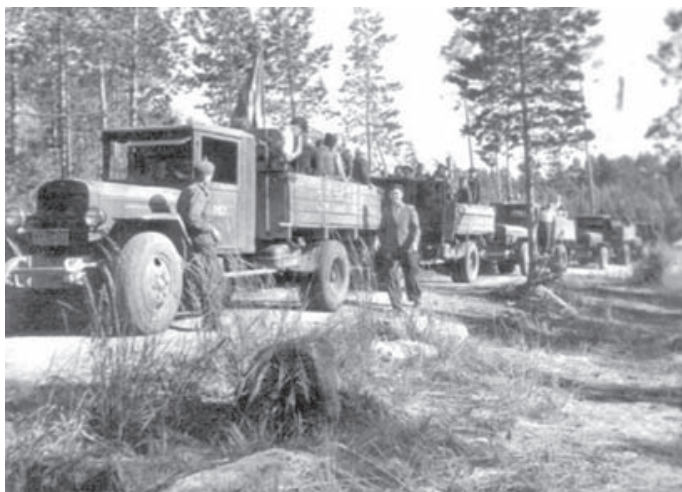
Колонна автомобилей военных строителей г. Свердловск-44.
