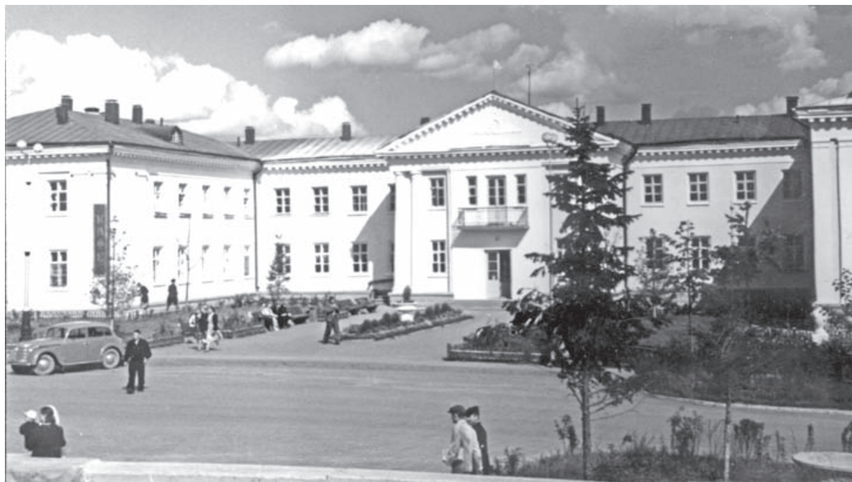
Здание городской гостиницы.
