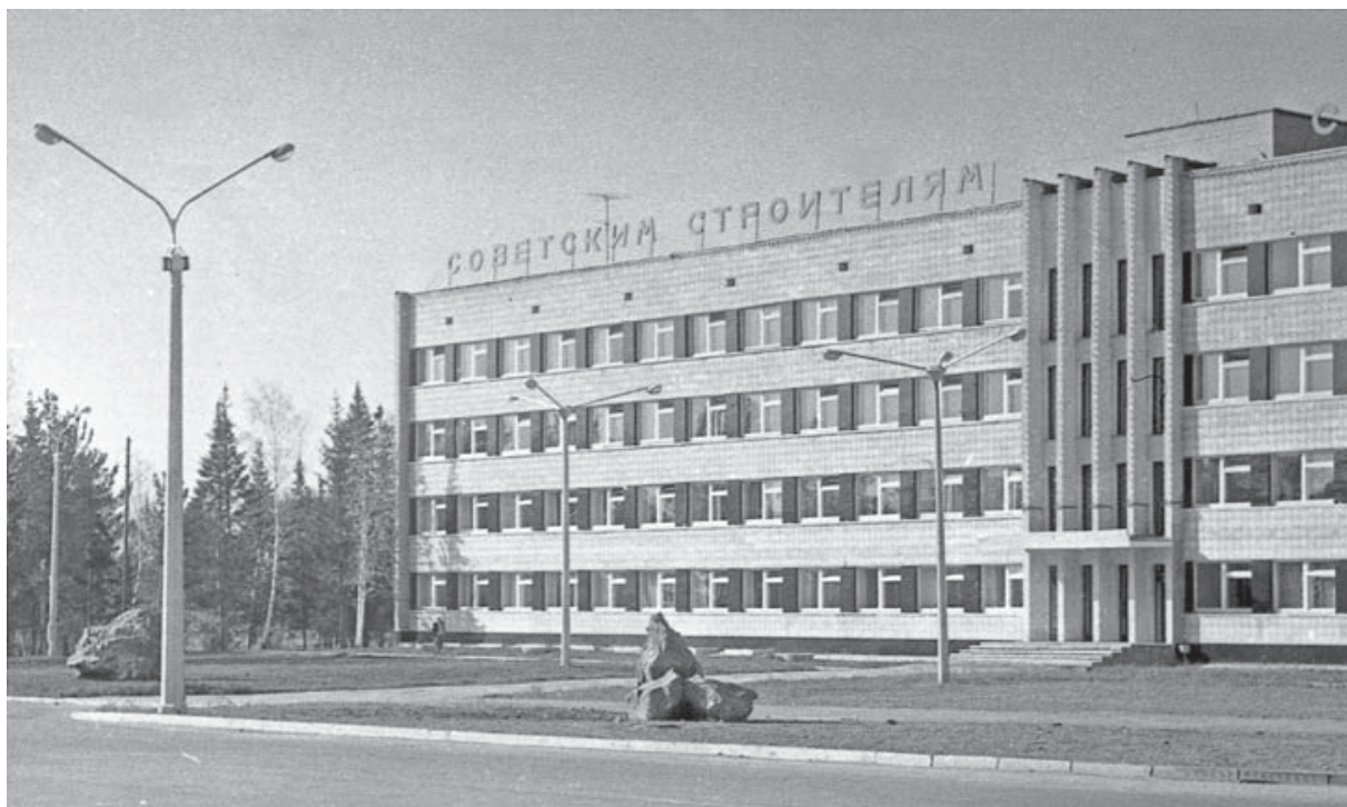
Здание управления строительства.
