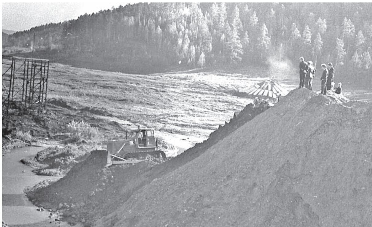
Строительство плотины пруда Смольный. г. Трехгорный.
