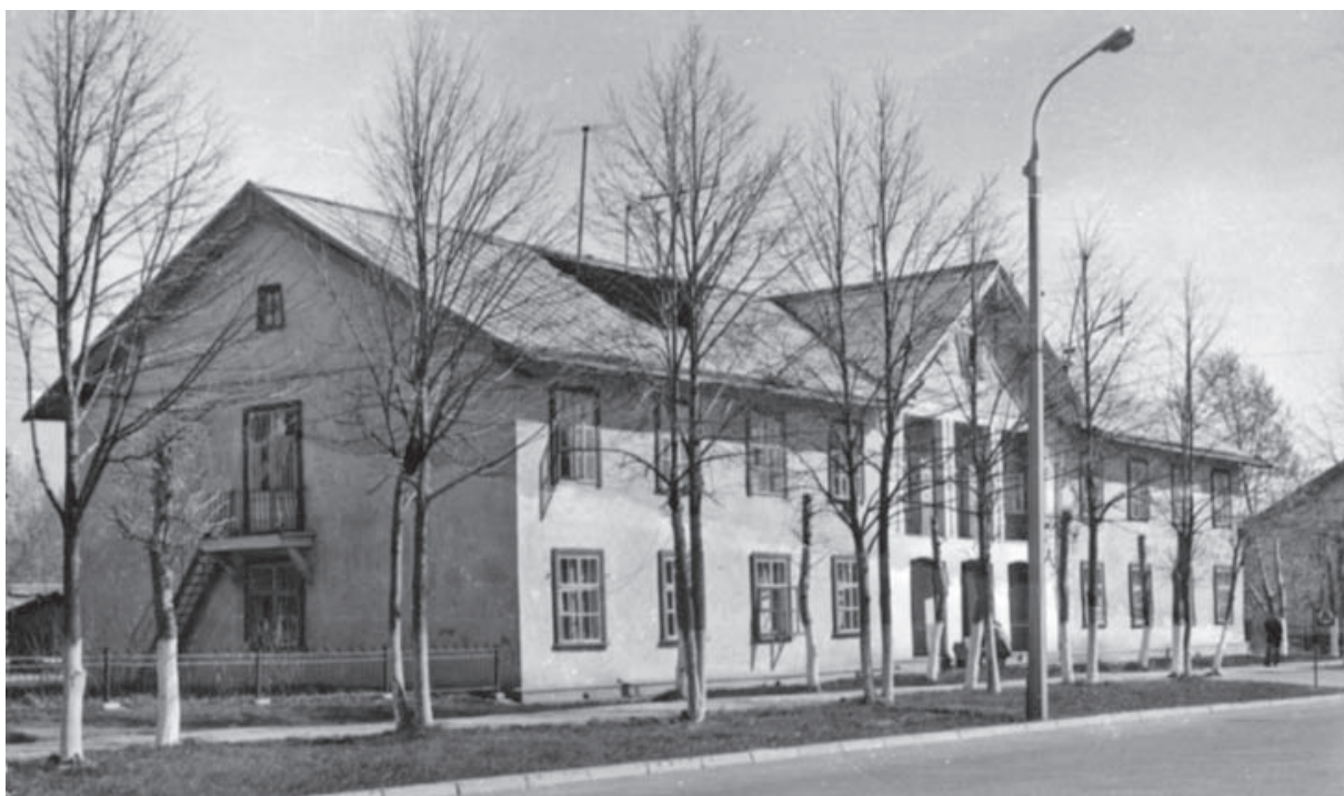
Одно из первых зданий по ул. Сталина. г. Свердловск-45.
