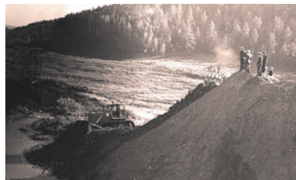
Строительство плотины Construction of the dam
