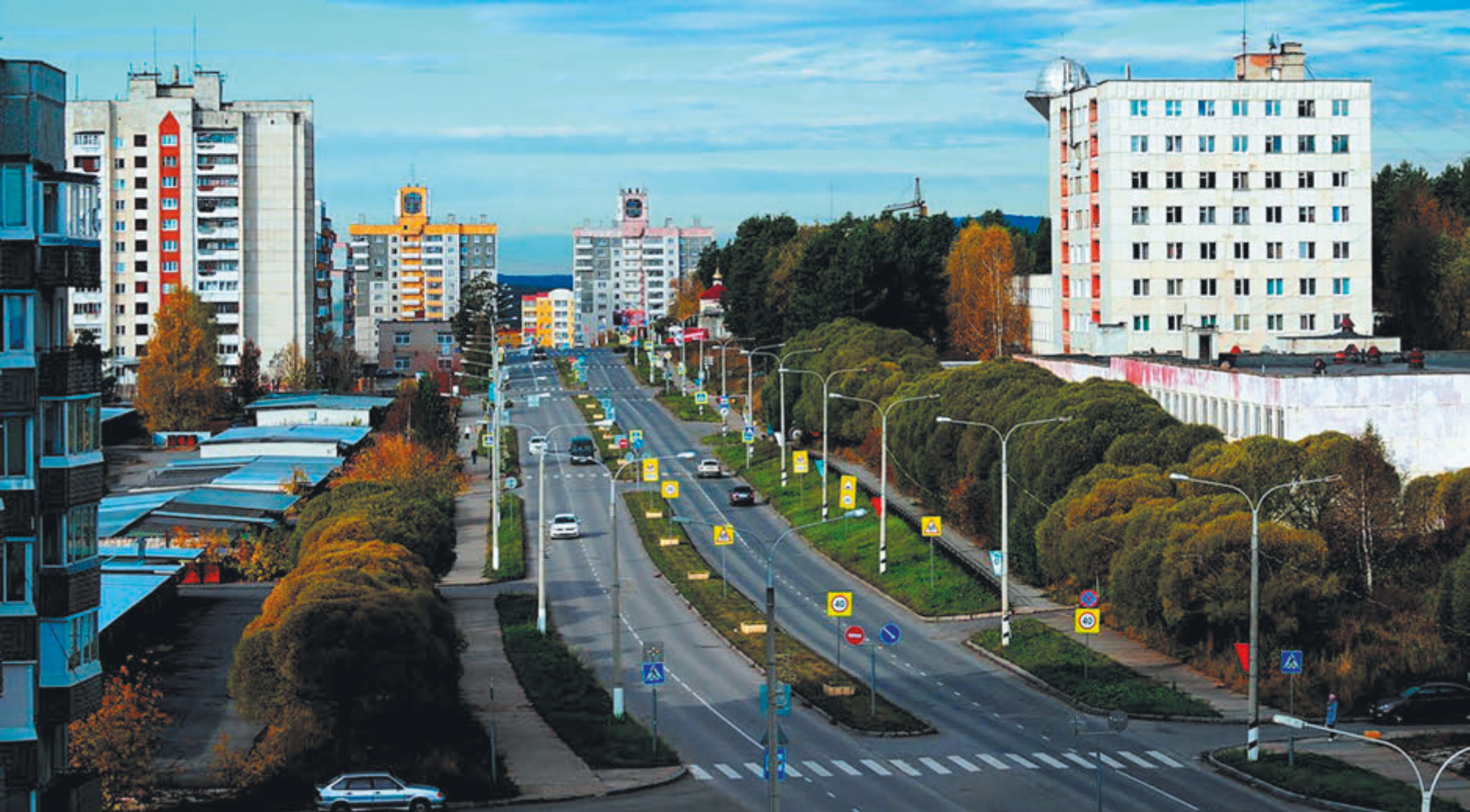
Улица строителей Stroiteley Street
