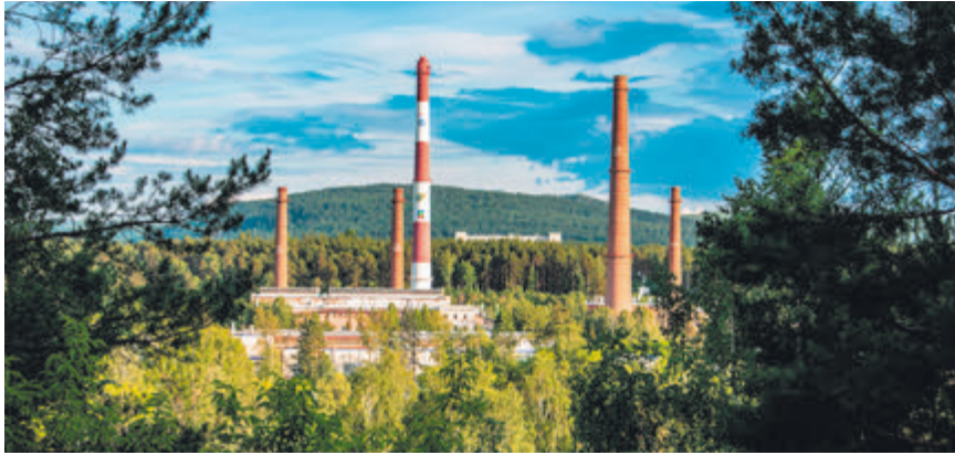
Вид на Приборостроительный завод View of the instrument-making plant
